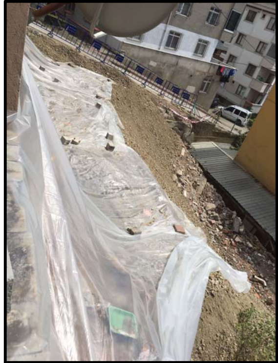
Fotoğraf 4 ve 5: Stabilize Malzeme Kullanılarak Oluşturulan Topuk.
