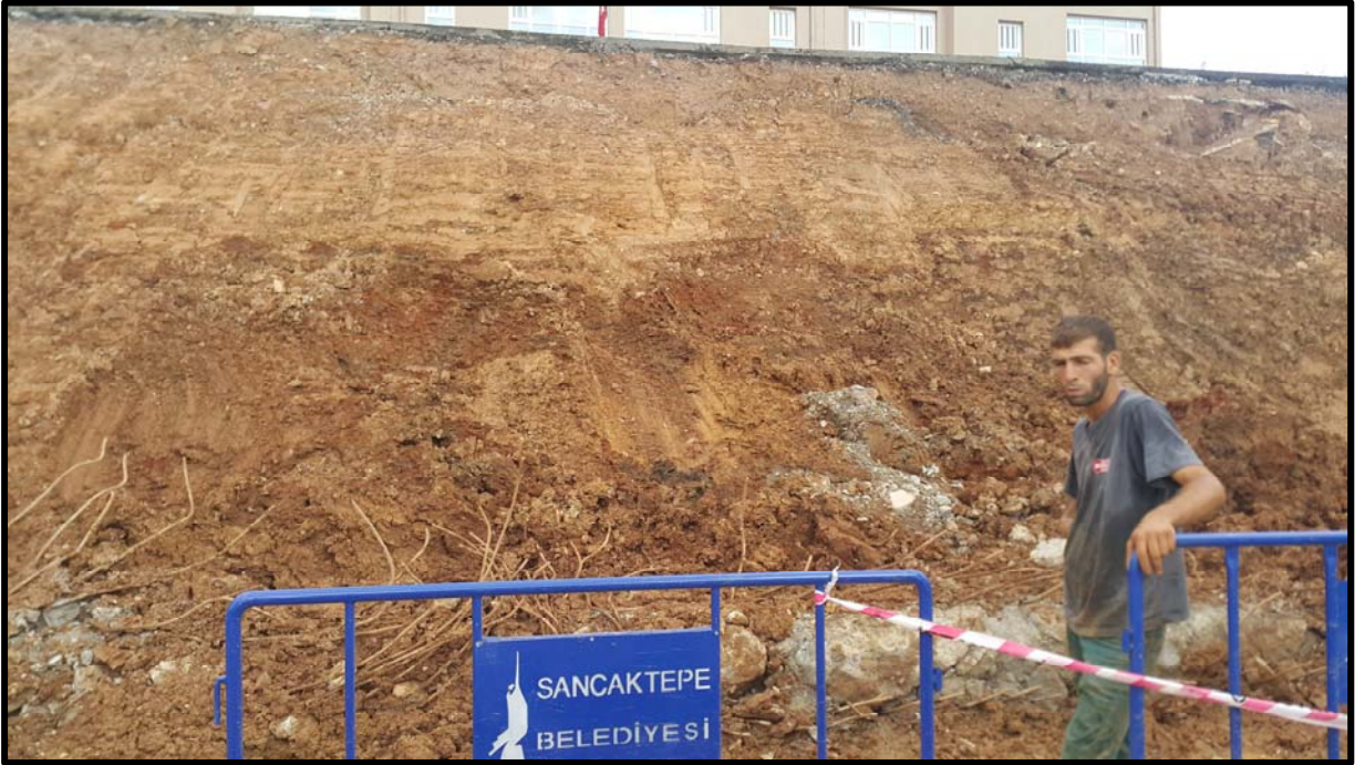
Fotoğraf 9: Dolgu İçerisinde Organik Kil ve Silt Malzemesinden Oluşan Düzeylerin Yakından Görünümü.
