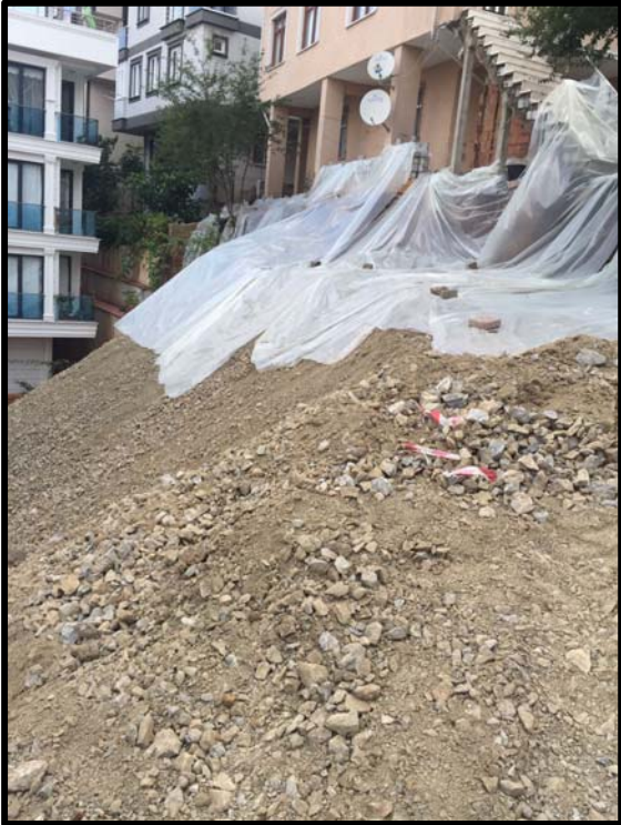
Fotoğraf 4 ve 5: Stabilize Malzeme Kullanılarak Oluşturulan Topuk.
