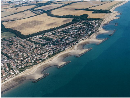
Şekil 3 Açık deniz dalgakıranları
