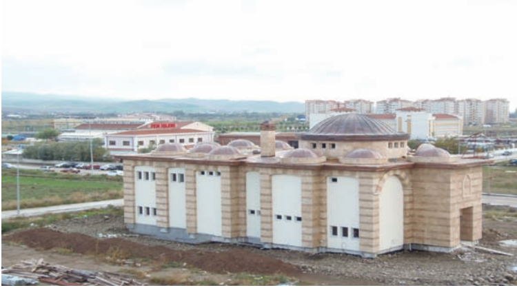
Şekil.13. Soğucak köyünden Kazan'a 9km taşınan sıcaksuyun kullanıldığı termal otel, kaplıca
