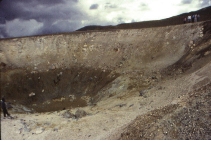
Foto.1. İzlanda Krafla Jeotermal sahasında kontrolsüz kuyu örneği (Karamanderesi, 1986)
