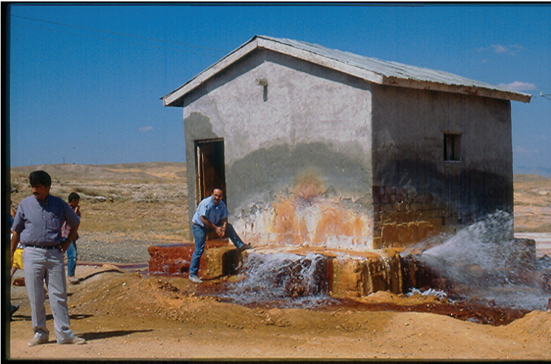
Foto.3. Sivas sıcak çermik DSİ tarafından soğuksu sondaj tekniği ile açılan tipik bir sıcak su kuyusu
