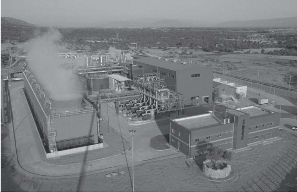
Şekil 10. Aydın-Germencik GÜRMAT-1 jeotermal elektrik santrali (47,4 MWe)
