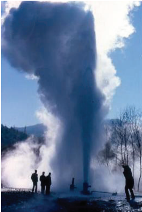
Foto. 5. Salihli Kurşunlu K-5 Kuyusu kuyu jeolojisindeki hatalar sonucu 115m de hazne kayaya girmiştir.
