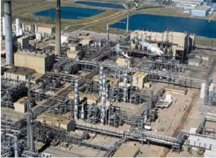
Şekil 3.12 Soğuk metanol, fiziksel solvent işlemi kullanan 3.3 Mton/yıl karbondioksit tutumlu Kuzey Dakota kömür gazlaştırma santrali
