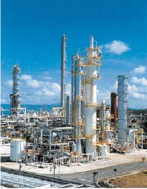
Şekil 3.5 Malezya’da 200 ton/gün KEPCO/MHI kimyasal solvent işlemi kullanılan CO 2 tutum tesisi.
