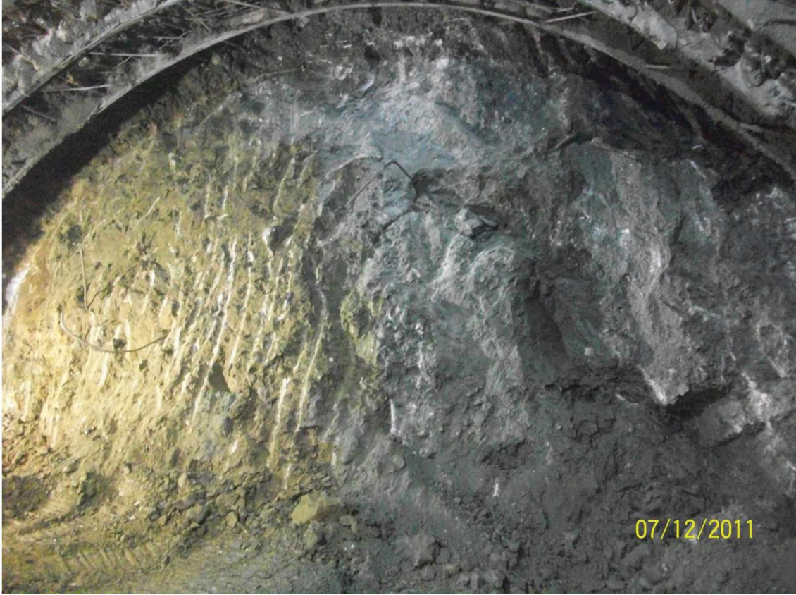
Şekil 6. Tünel üst yarı kazı aynası.
