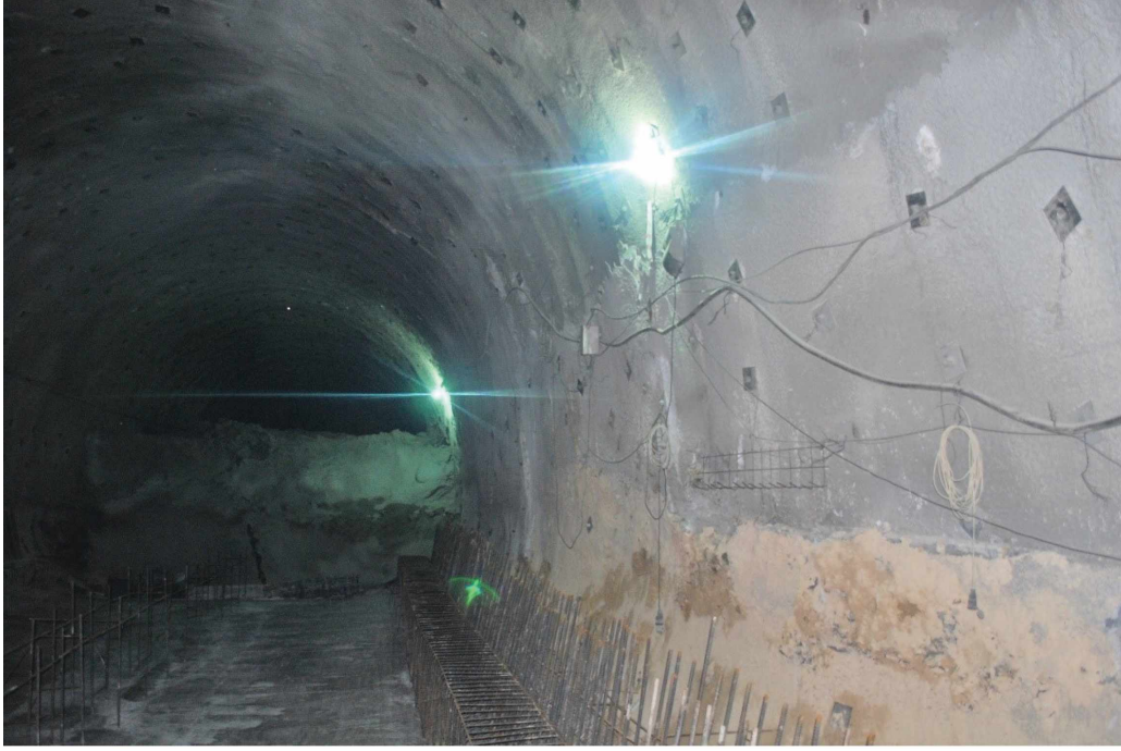
Şekil 9. Tünelin taban kemer betonunun tamamlanmış hali.
