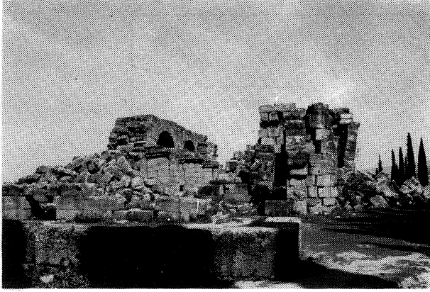
Şekil 3. Kuzey hamamı. Binanın duvarları eğilmiş ve çatlamış, duvarlardaki bloklar rotasyon yapmış.
