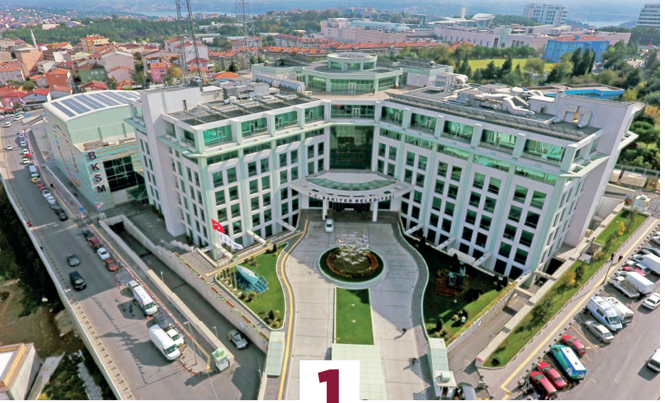
Eko-Belediye Hizmet Binasının İnşası
