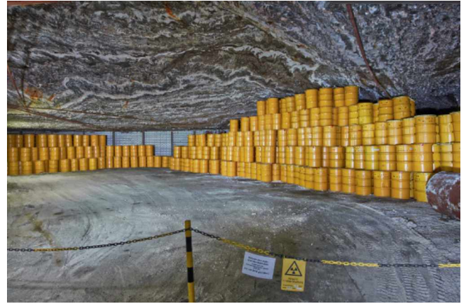
Şekil 1. Morsleben, Almanya'da 500 metre derinliğinde bir jeolojik nükleer atık deposu [5].
