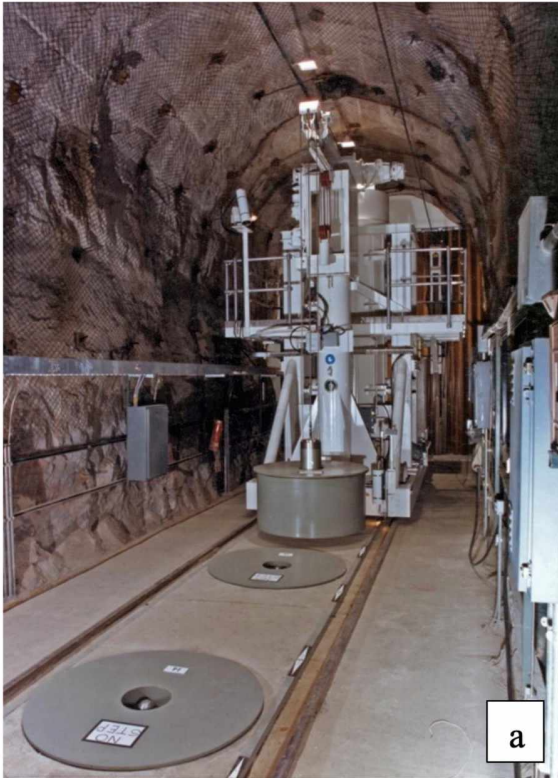
Şekil 2. (a) Nevada test alanında granitlerde atık imha alanları [6]; (b) İsveç'te çok bariyerli derin jeolojik nükleer atık deposu [7].
