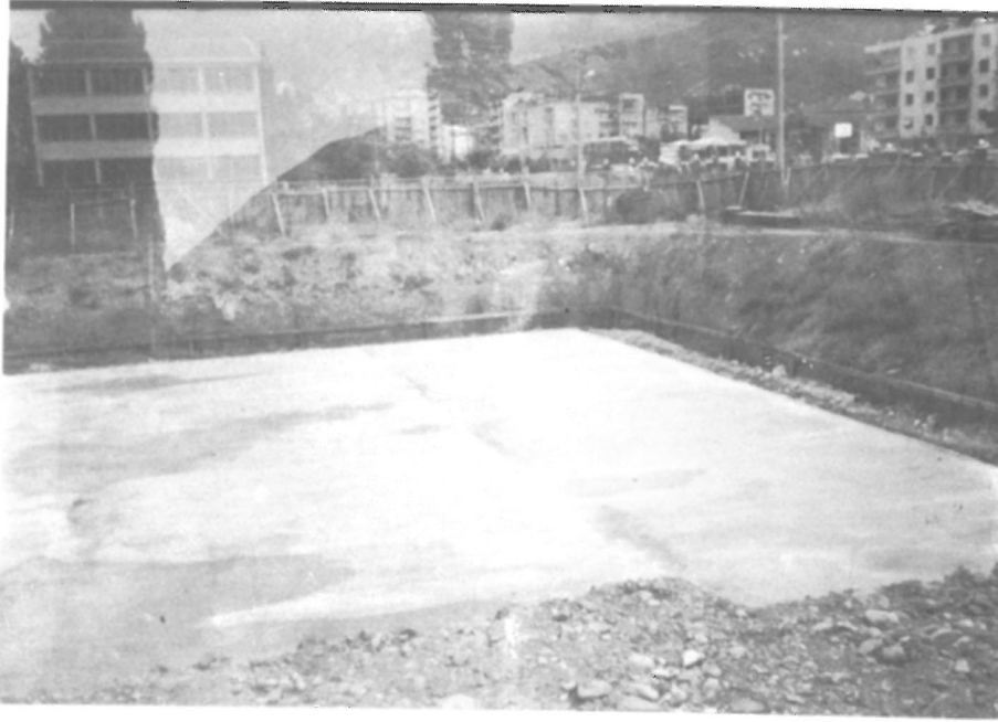
D- 1 Haziran 1992 - Manisa Öğretmenevi Zemin islahı sonrası 10 cm. lik Grobeton evresi.
