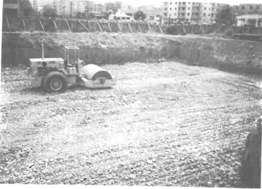
C - 26 Mayıs 1992 - Manisa Öğretmenevi Zemin islahı sonrası sıkıştırma işlemi.
