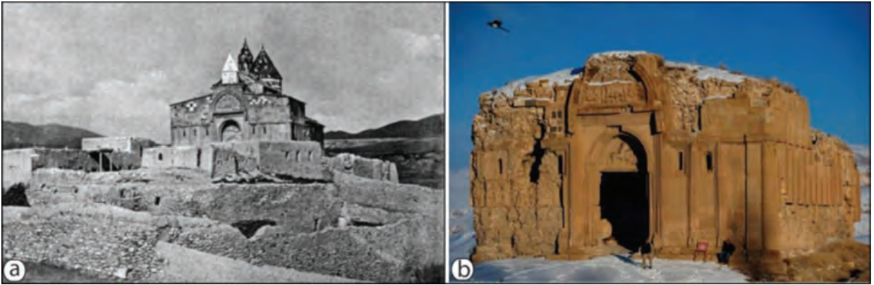
Şekil 10. a) St Bartholomeus kilisesinin 20.yy başlarındaki (Bachmann, 1913) ve b) günümüz görünümü
