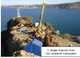
3. Boğaz Köprüsü Kule Yeri Jeoteknik Çalışmaları
