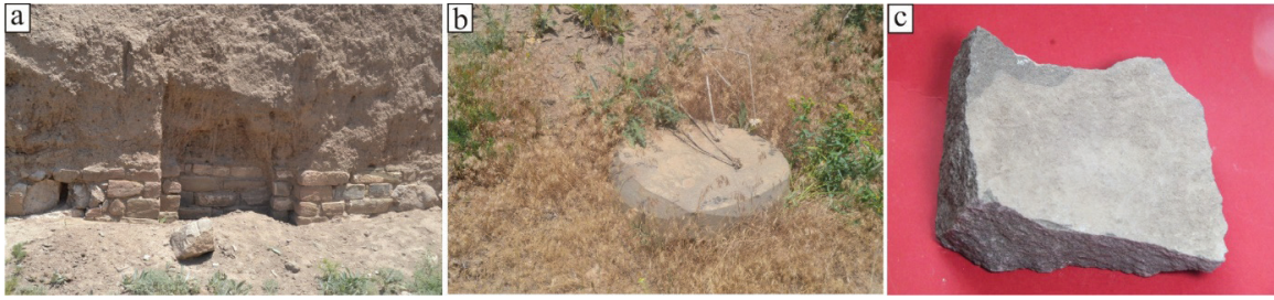
Şekil 7. a, b, c) Yukarı Anzaf Kalesi sitadel alanındaki yapı temellerinde kullanılan kumtaşı bloklar ile yazısız kumtaşı bir sütun altlığı ve kayaç örneği (Örnek No: V21).
