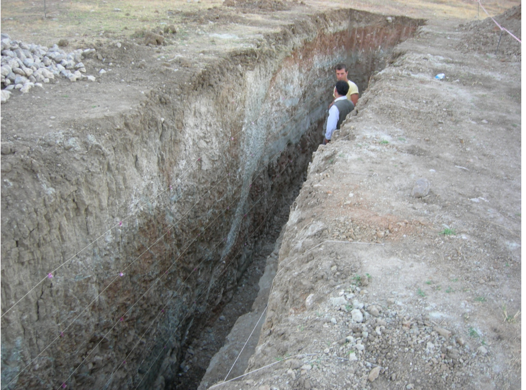
Hendek duvarı karelajlama ve loglama çalışmaları
