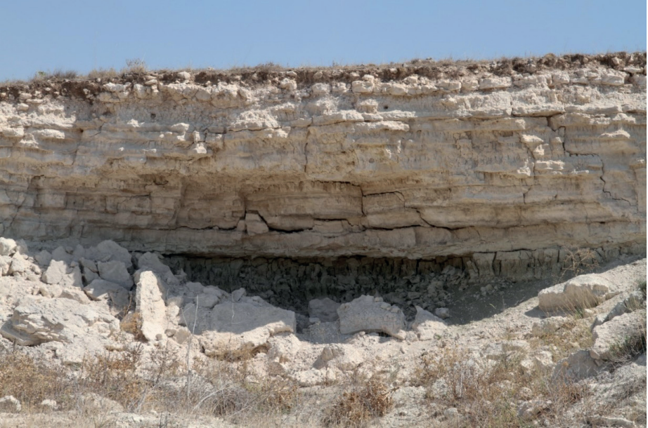
Şekil 21. Sahada bir obruk oluşumunu gösteren yol yarması kesiti.
