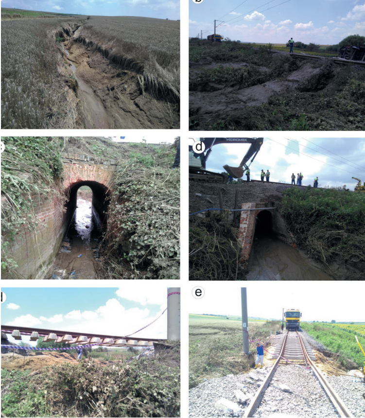
Şekil 6: Havza içerisinde gelişmiş sel yarıntısı (a), derenin getirdiği çamur malzemenin tren yolu menbaında görünümü (b), tren yolu altındaki menfezin menba ve mansaptan görünümü (c menba, d mansap), askıda kalan raylar (d) ve onarılmaya başlanan rayların (e) görünümü
