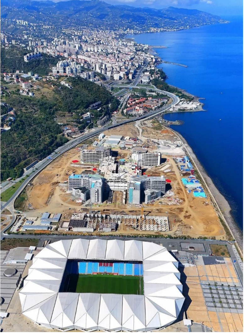
Dolgu alanına yapılan Trabzon Akyazı Stadı ve yapımı süren şehir hastanesi
