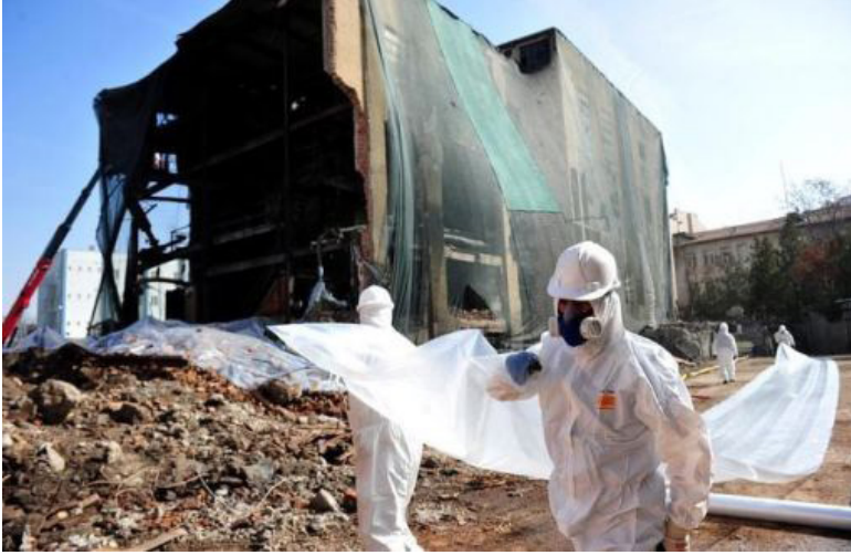
Ankara Havagazı Fabrikası sökümü
