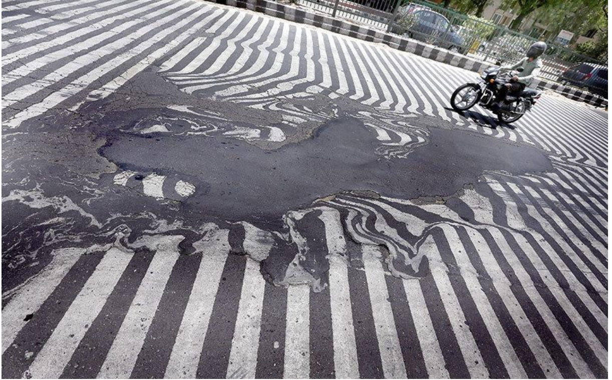
Hindistan'da 50°C'ye varan sıcaklıklar nedeniyle yollar eridi (kaynak: www.telegraph.co.uk )
