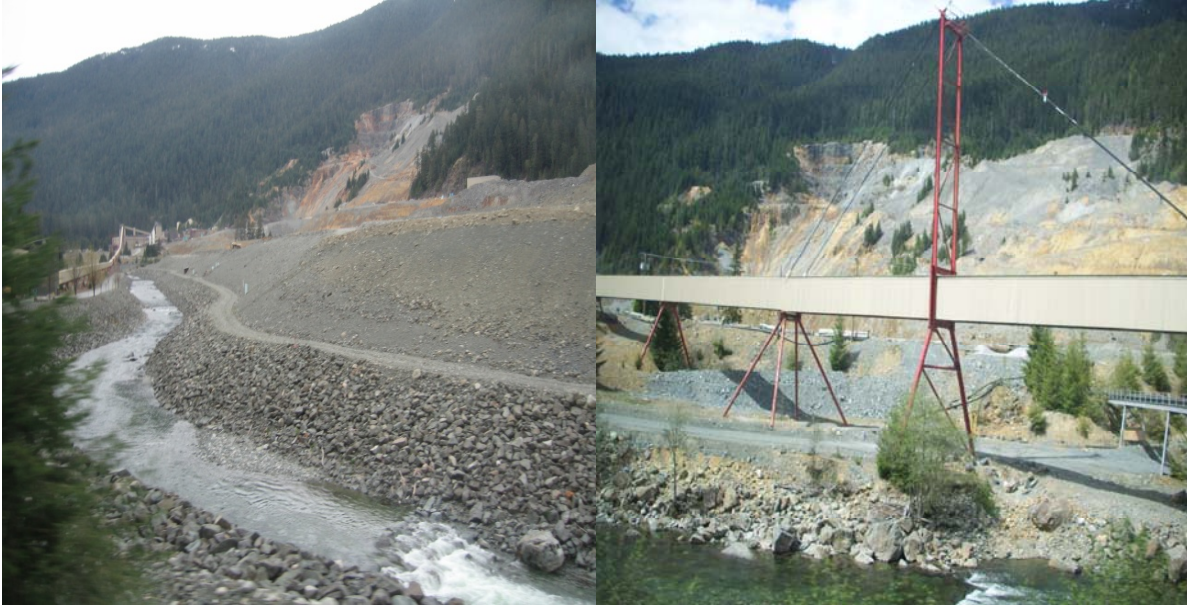
Resim 32. Tesislerden, Kasabanın İçme Suyunu Karşılamanı İrmağına Su Bırakılması
