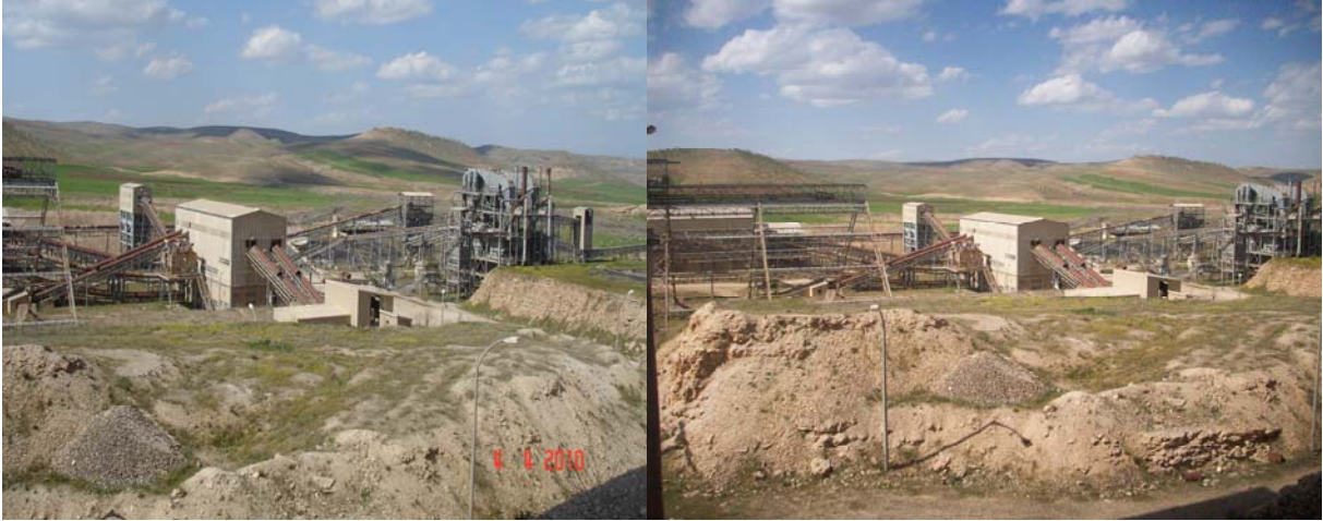
Resim 29. Atıl Durumdaki Mardin Mazıdağı Fosfat Tesisleri
