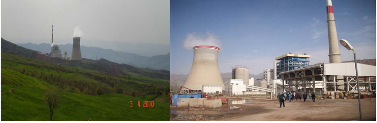
Resim 23. Silopi Termik Santrali
