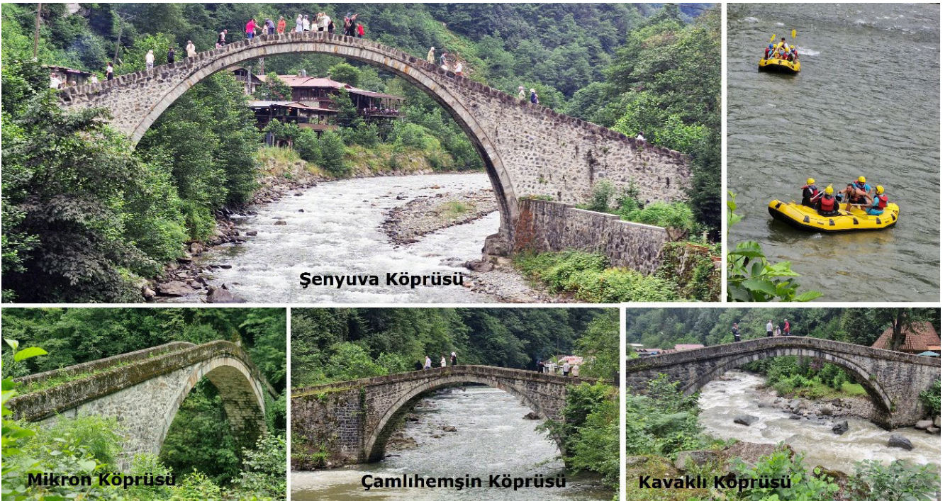
Şekil 17. Fırtına Dersindeki bazı tarihi kemer köprüler ve raftingciler
