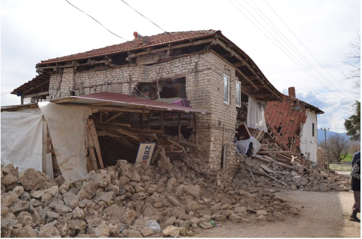
Şekil 14. Ucar Mahallesinde ağır hasarlı kerpiç yığma binalar.
