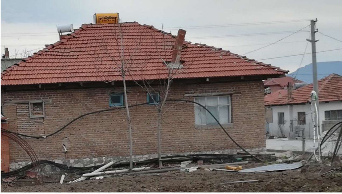
Şekil 21. Apa mahallesinde hafif hasarlı dolu tuğla ile yapılmış yığma bina.
