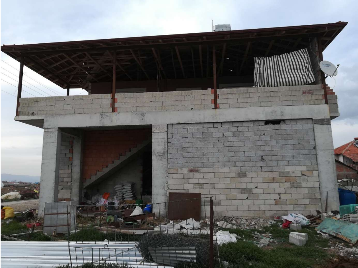
Şekil 22. Apa mahallesinde hasarsız betonarme bina.
