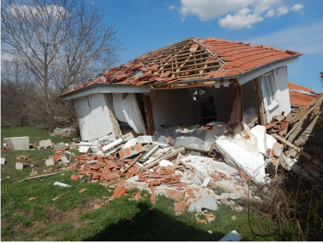
Şekil 25. Kırca Mahallesinde duvarları G60°B'ya devrilmiş delikli tuğla ile yapılmış yığma yapı.
