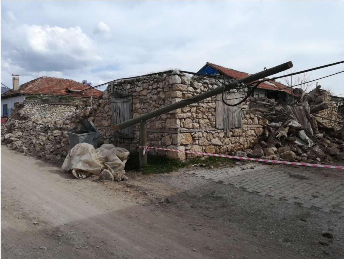
Şekil 15. Ucar mahallesinde kırılmış ve devrilmiş telefon direği ve devrilmiş taş yığma duvarın görünümü.
