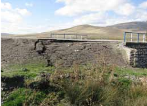
Şekil 35. Van-Erciş karayolunun yamacında meydana gelen heyelan (sol üst), bu heyelanın yolda meydana getirdiği deformasyonun tamir edilmiş hali (sağ üst), Göllü köyü yolu üzerinde meydana gelen deformasyonların menfez (sağ alt) ve yol üzerinde oluşturduğu deformasyon (sol alt).
