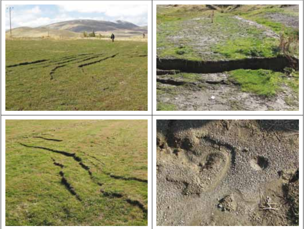
Şekil 12. Göllü ve Alaköy çevresinde gelişen yanal yayılma ve sıvılaşma yapılarına ait arazi fotoğrafları. Sol üst fotoğrafta gelişen dairesel çatlaklar yüzeye çıkamayan sıvılaşma yapısının varlığına işaret eder. Sol alt fotoğrafta yanal yönde devamsız ters fay geometrisi sunan yüzey deformasyonları gözlenmektedir. Sağ üst fotoğrafta gelişen normal fay geometrili deformasyonları ve sağ alt fotoğraftaki sıvılaşma yapıları bölgede gelişen yanal yayılma ve sıvılaşmanın değişik doğrultulu oturma yapılarıyla sonuçlandığını göstermektedir.
