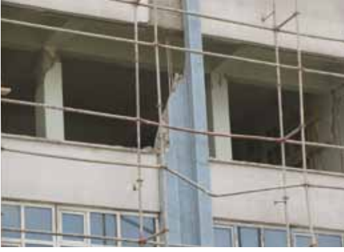
Şekil 25. Van merkezde SGK binası (A), MTA Doğu Anadolu Bölge Müdürlüğü Hizmet binasında (B) meydana gelen hasarlar.
